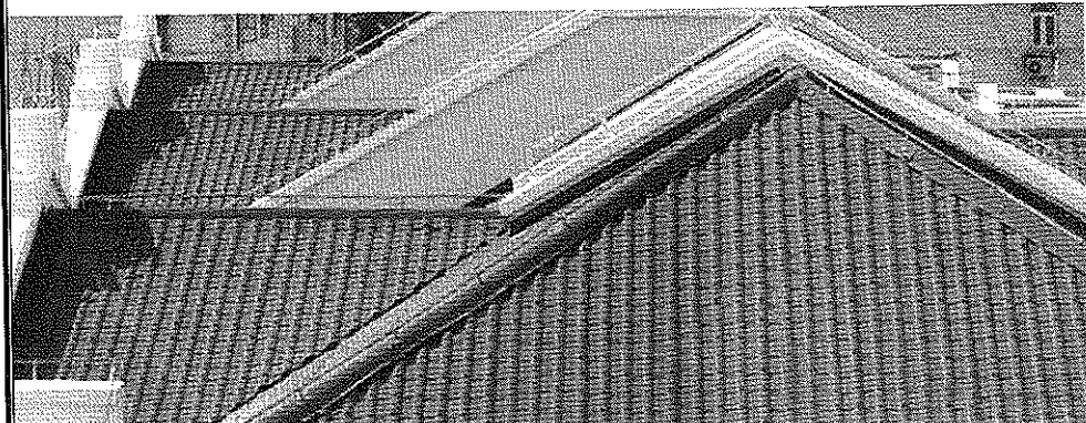
合成树脂筒形瓦可用于新建建筑坡屋顶 及既有建筑平改坡
