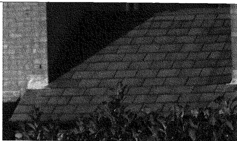
合成树脂平板瓦可用于坡屋面屋顶或外墙面作装饰
